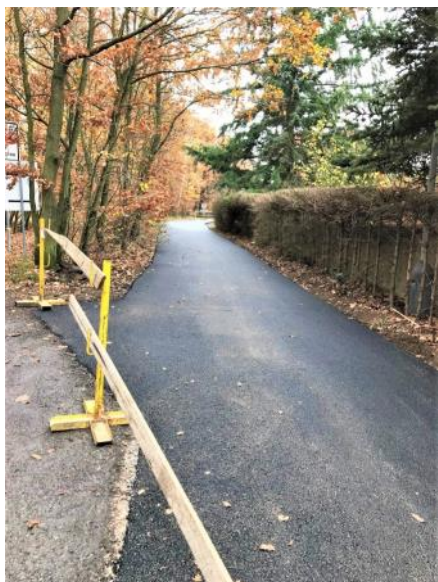
Opravené pokračování ulice Pod Hájovnou
