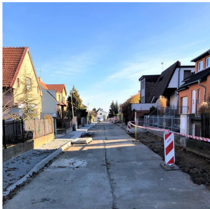
Rozpracovaná oprava 2. části ulice K Lažance
